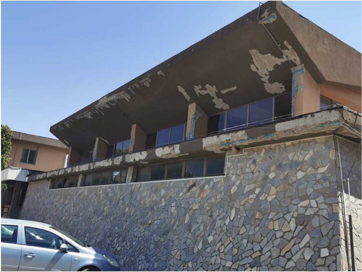
Facciata Ovest (SALA DI CONTRATTAZIONE)
