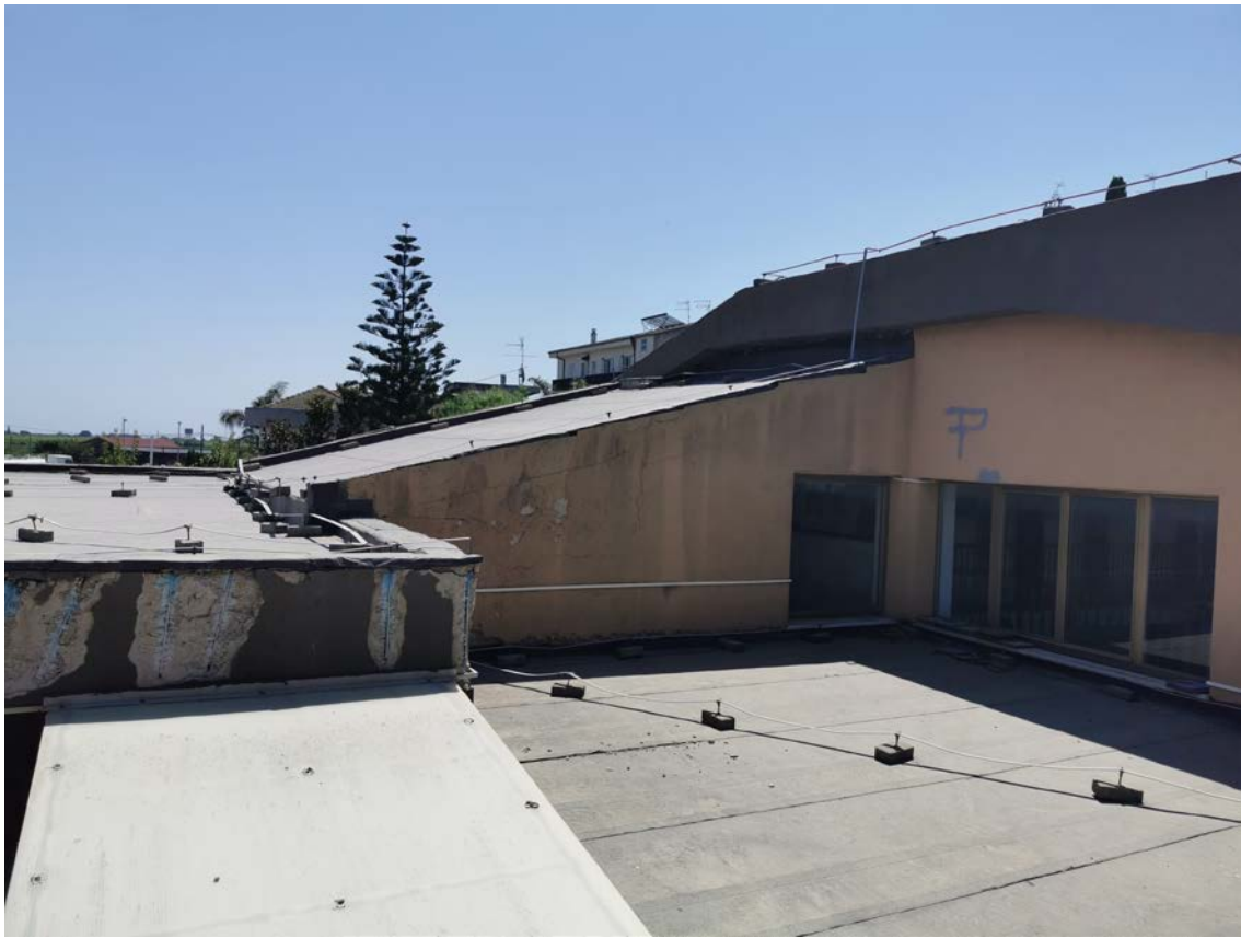
Facciata Nord-Ovest (SALA DI CONTRATTAZIONE)
