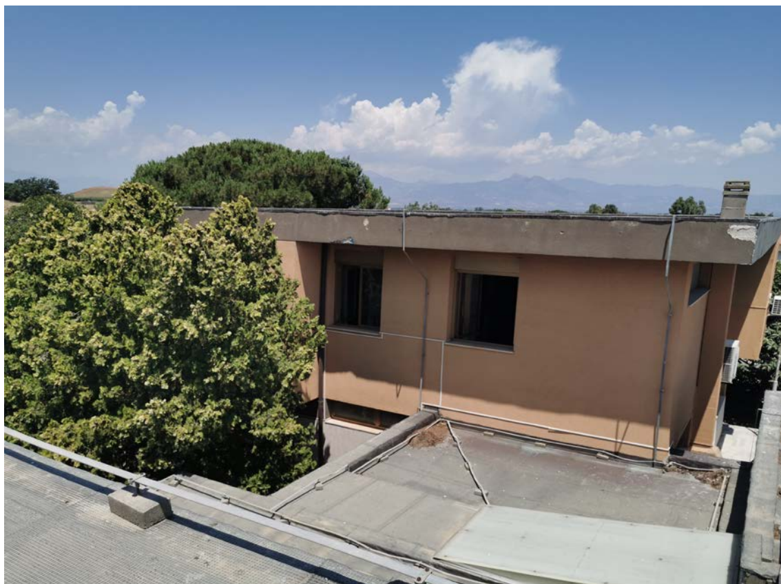
Facciata Sud (UFFICI)
