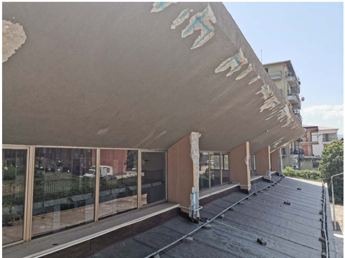
Facciata Ovest (SALA DI CONTRATTAZIONE)
