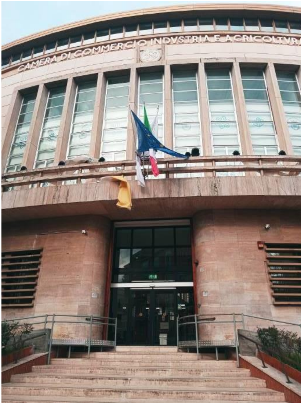
Particolare del prospetto principale
